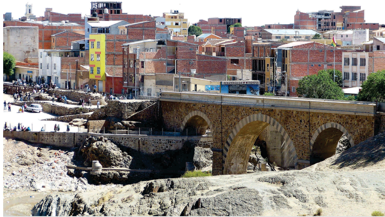
► Puente internacional Horacio Guzmán, Villazón – La Quiaca. Fotografía de Mariano Mantel, extraída de Flickr.
