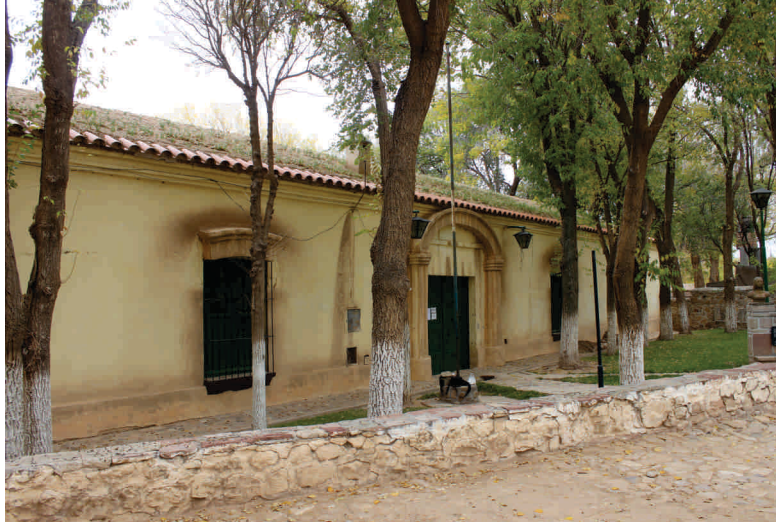
► Casa del Marqués en Yavi Fotografía: Julieta Barada y Jorge Tomasi
