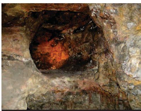
Desprendimiento por aplicación de fuego
